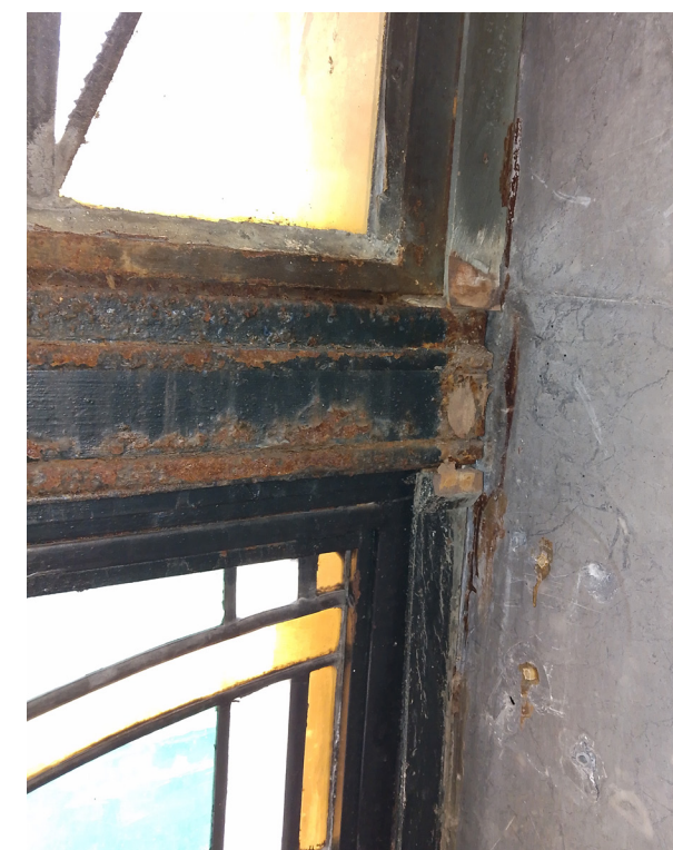
Structures métalliques corrodées
